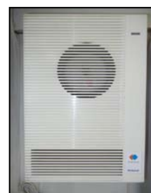
熱交換型換気扇
