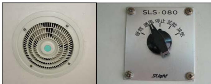
図1 天井扇および換気スイッチ
